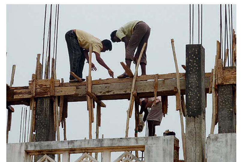
Bauarbeiter betonierten im Januar die tragenden Teile im künftigen Obergeschoss der St.-Josephs-Schule.
