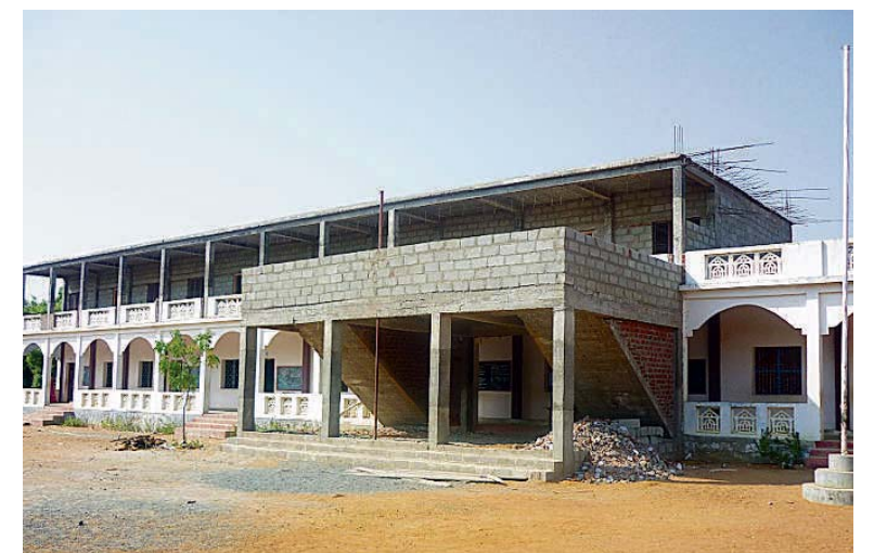
So sah der Rohbau der Erweiterung der High-School aus, mittlerweile sind die Klassenräume fertig. FOTO: THOMAS
